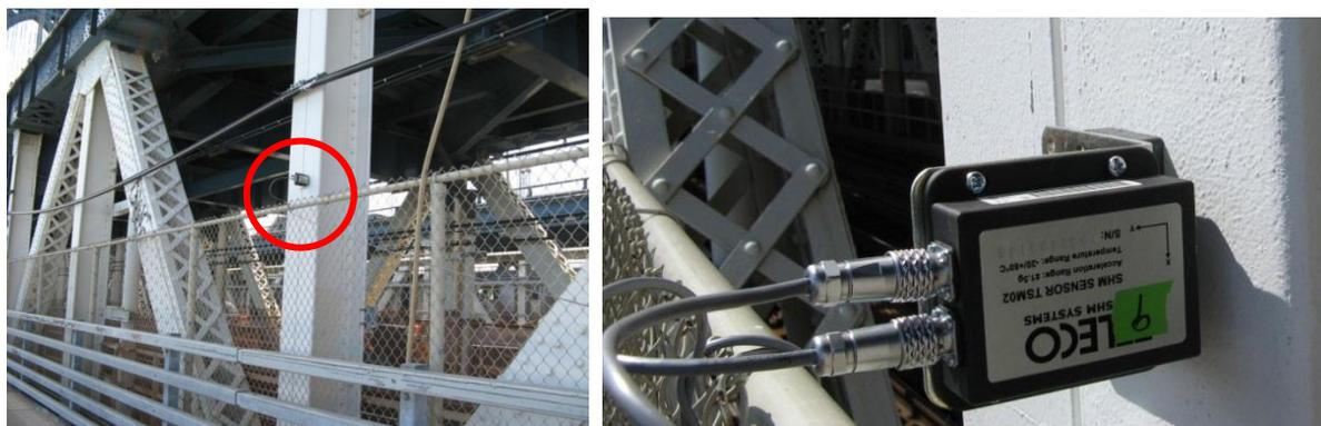
Figura 3. Esempio di strumento posizionato su un montante del ponte.
